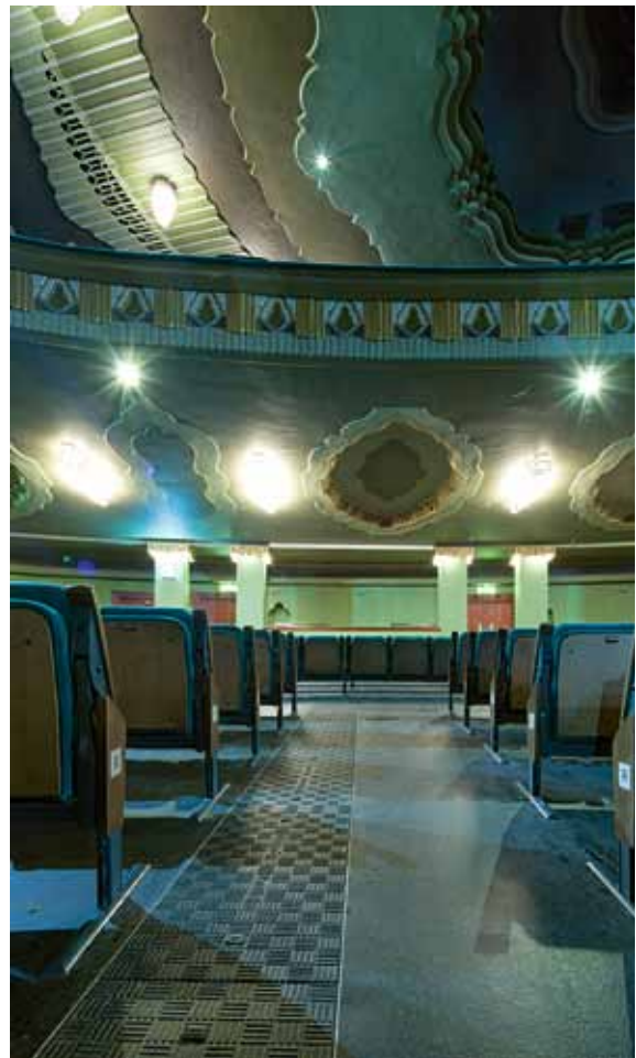
Faserverbundabdeckungen mit rutschhemmender Oberfläche
