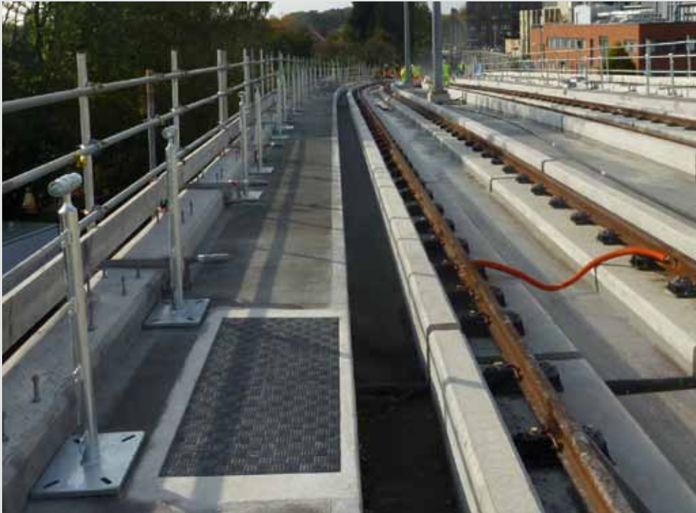
Faserverbundabdeckungen in Belastungsklasse B (12,5 t)
