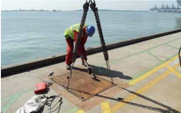
Arbeitsintensive Vorgehensweise bei der Entfernung der bestehenden Abdeckungen
