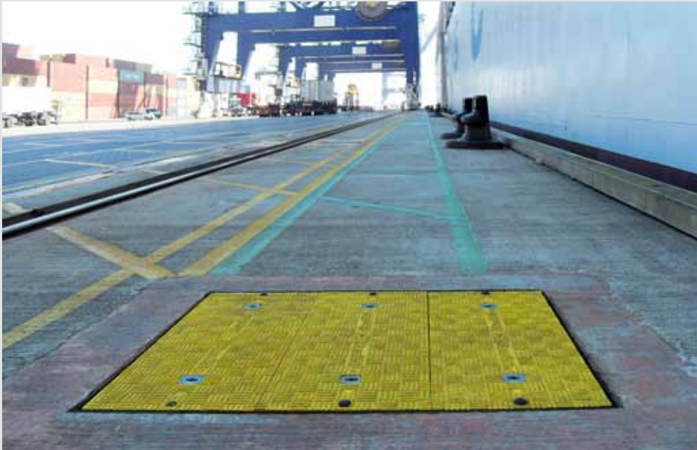
Die 90 t belastbare, leichte Faserverbund-Schachtabdeckung vor einem Kai
