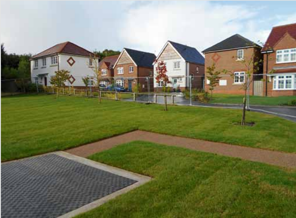
Eingepasste Faserverbundabdeckungen in Belastungsklasse B (12,5 t) und das Erscheinungsbild der Abdeckungen fügt sich angenehm in die Umgebung ein
