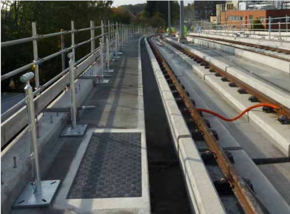
Faserverbundabdeckungen in Belastungsklasse B (12,5 t)
